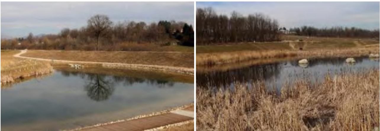
Intervento realizzato delle "Aree di Laminazione del Torrente Lura"
