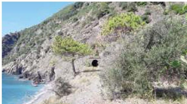
L'esterno della galleria, nella zona del ritrovamento
