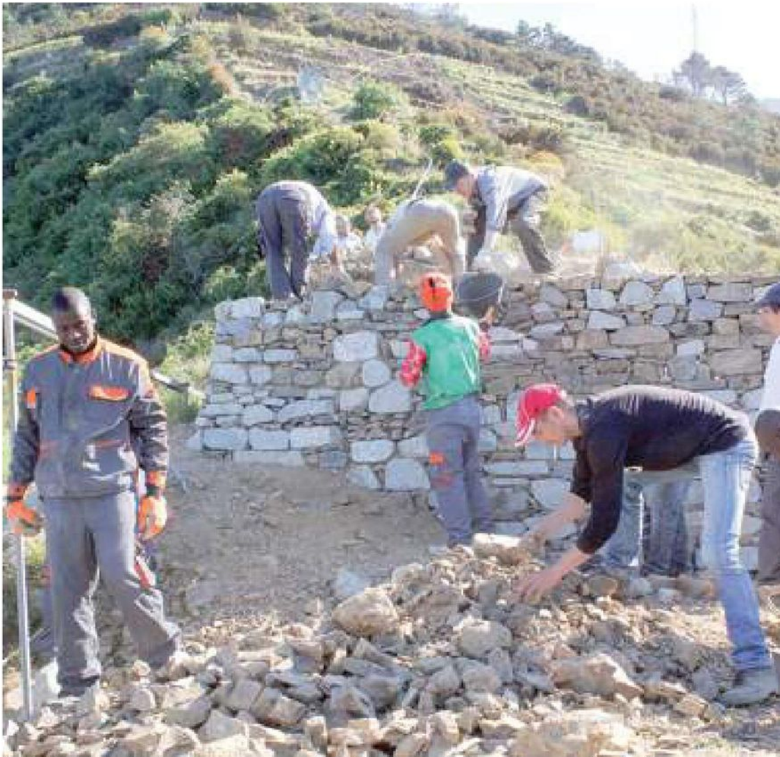
Cinque Terre: un gruppo di profughi al lavoro per ripristinare un muretto a secco
