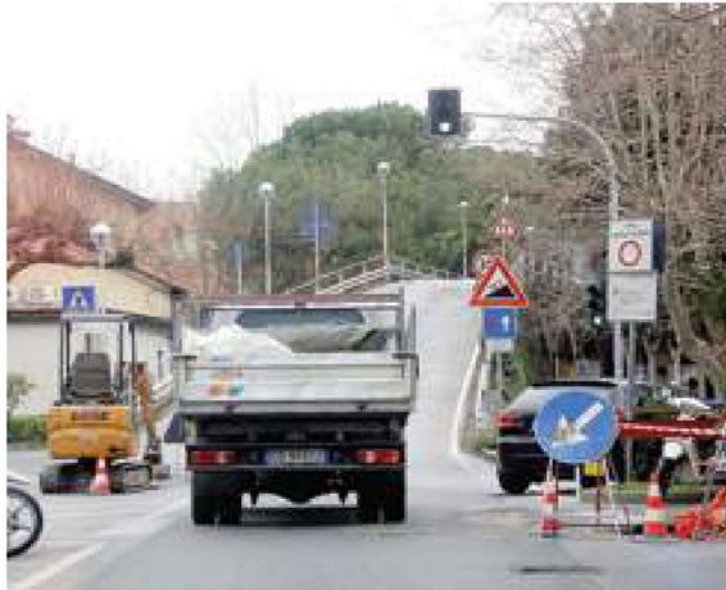
Levanto: il cantiere per potenziare la rete idrica
