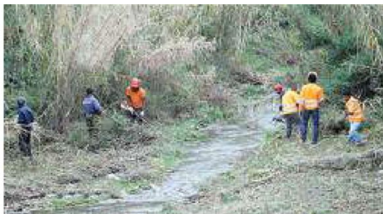
Squadre al lavoro per la pulizia dei torrenti dell'entroterra
