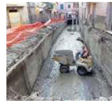
I lavori dopo l'alluvione 2011
