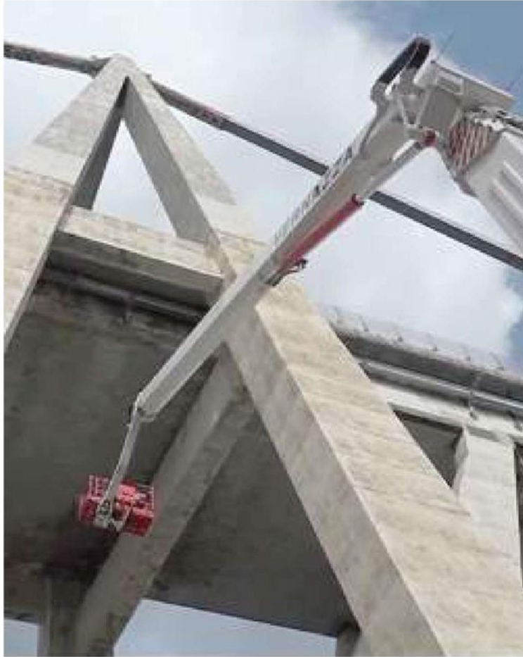
Per l'installazione del dispositivo utilizzata una gru alta 103 metri
