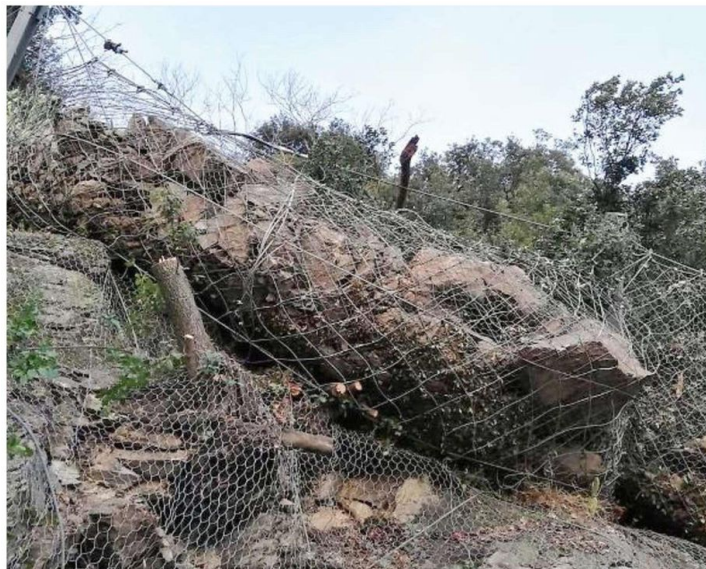
Nel corso della giornata di sabato il masso precipitato dalla parete del castello di Monterosso è stato ingabbiato con cavi di acciaio e ancorato retrostante parete rocciosa
