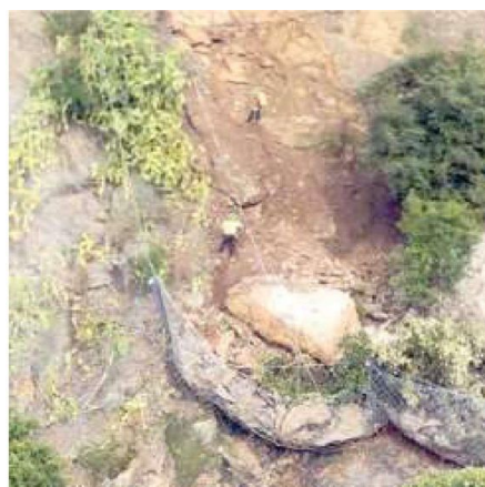
Rocciatori e geologi lavorano per assicurare il masso alla collina
