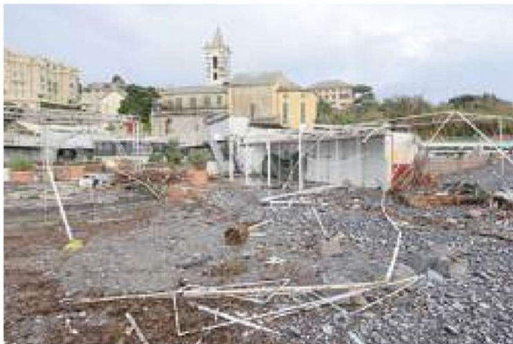
Uno stabilimento balneare distrutto a Genova
