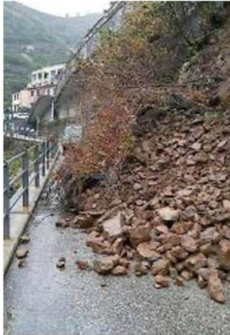
RIOMAGGIORE La frana che blocca la strada
