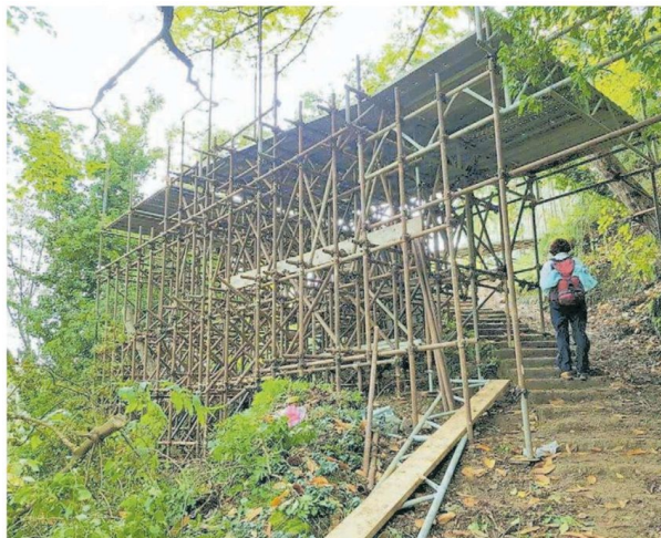
La pista sopraelevata realizzata nel bosco per consentire il passaggio a moto e scooter
