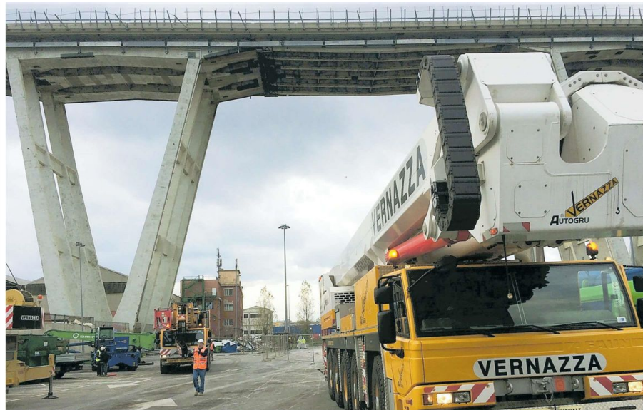
I lavori in corso Il cantiere di demolizione del viadotto Polcevera: in Via Porro è in corso l'assemblaggio a terra delle torri per la messa in sicurezza della pila 10, a ponente si separano i materiali di risulta
