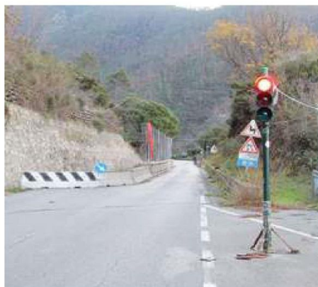
Il cantiere nella zona della Zorza: via ai lavori dopo l'estate
