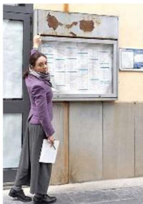
Pannelli informativi arrugginiti
