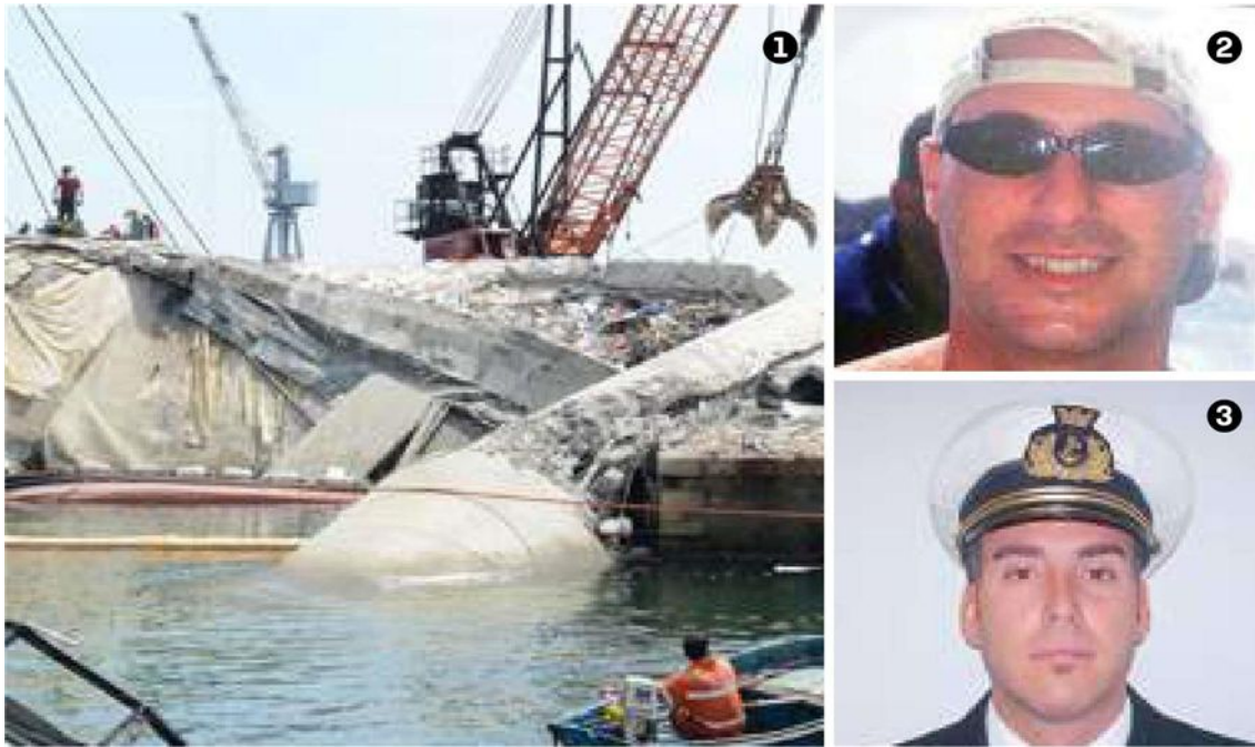
1. Le operazioni di rimozione delle macerie della Torre Piloti e delle altre strutture collassate dopo l'impatto con la Jolly Nero. 2. Sergio Basso, di Vernazza. 3. Gianni Iacoviello, nato alla Spezia
