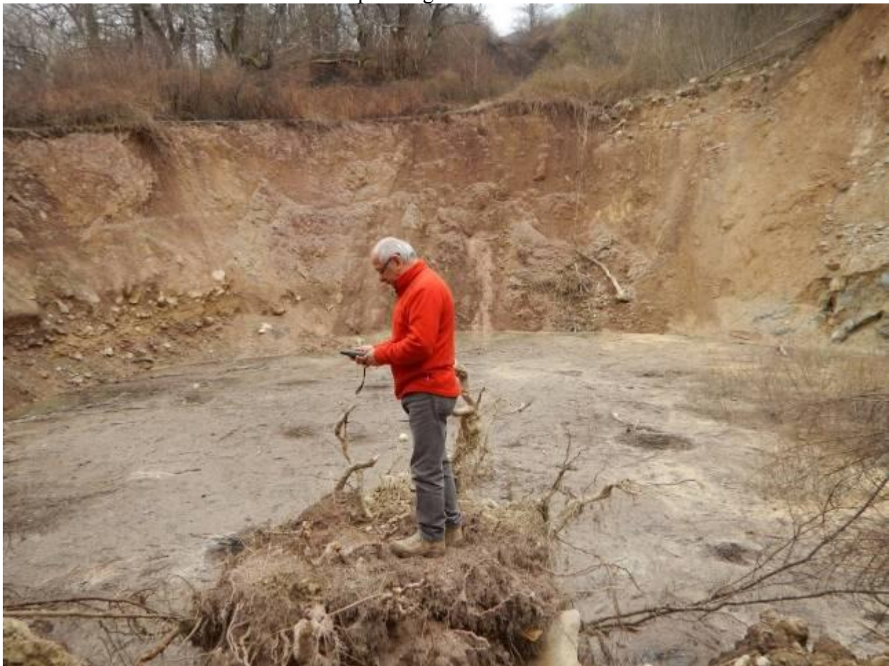
Sinkhole di Sassalbo, versante di monte (est)
