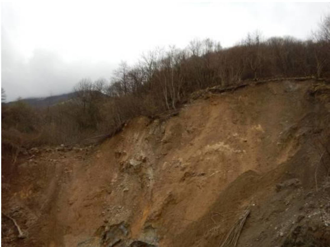
Sinkhole di Sassalbo, versante di monte
