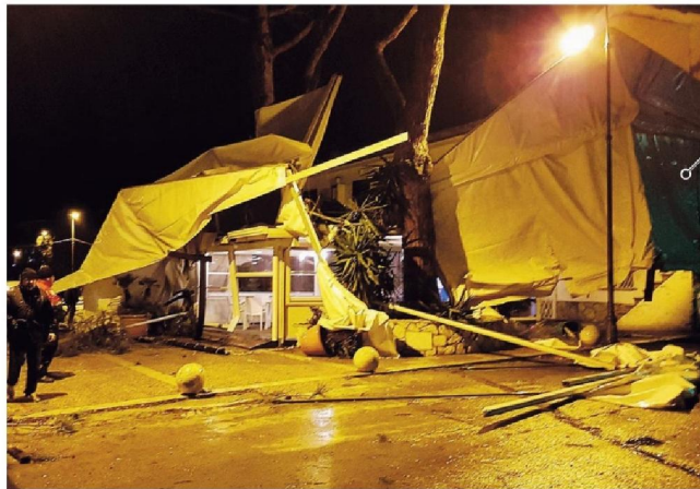
La tensostruttura precipitata ieri pomeriggio a Montenero
