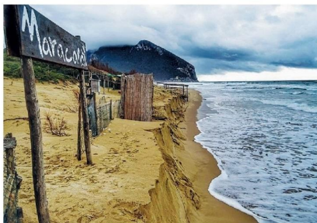
Alcune immagini dei danni causati dall'erosione e in basso a sinistra il sopralluogo sul lungomare
