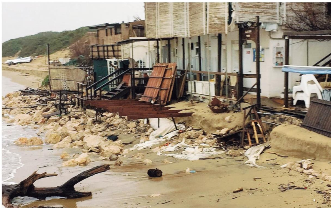
I danni causati dall'erosione
