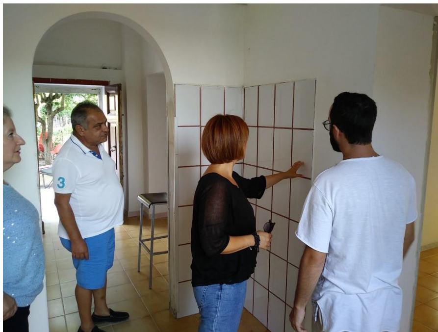
Supervisione dei lavori di ristrutturazione della casa cantoniera
