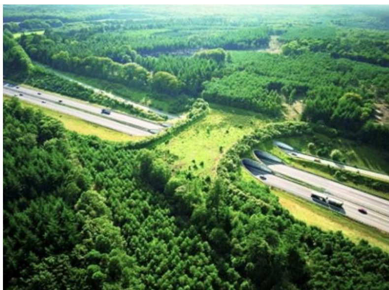
Esempio di corridoio ecologico, infrastruttura verde che concederebbe alla fauna selvatica la possibilità di migrare e raggiungere altre aree protette in totale sicurezza, per essi stessi e per il substrato antropico urbanizzato esistente
