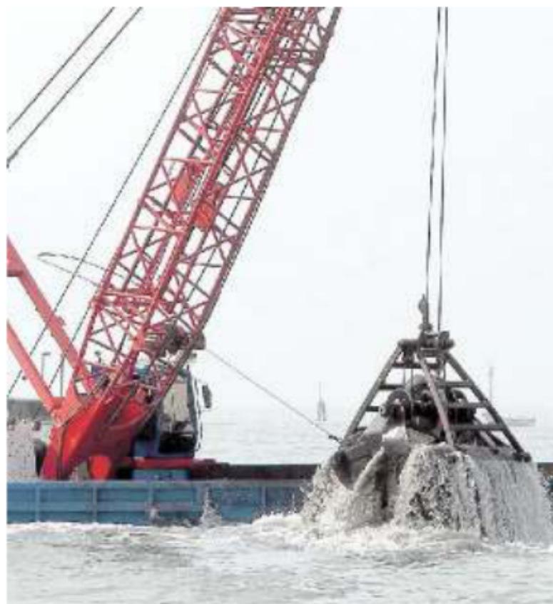
PORTO TOLLE Una draga al lavoro per l'escavo delle lagune
