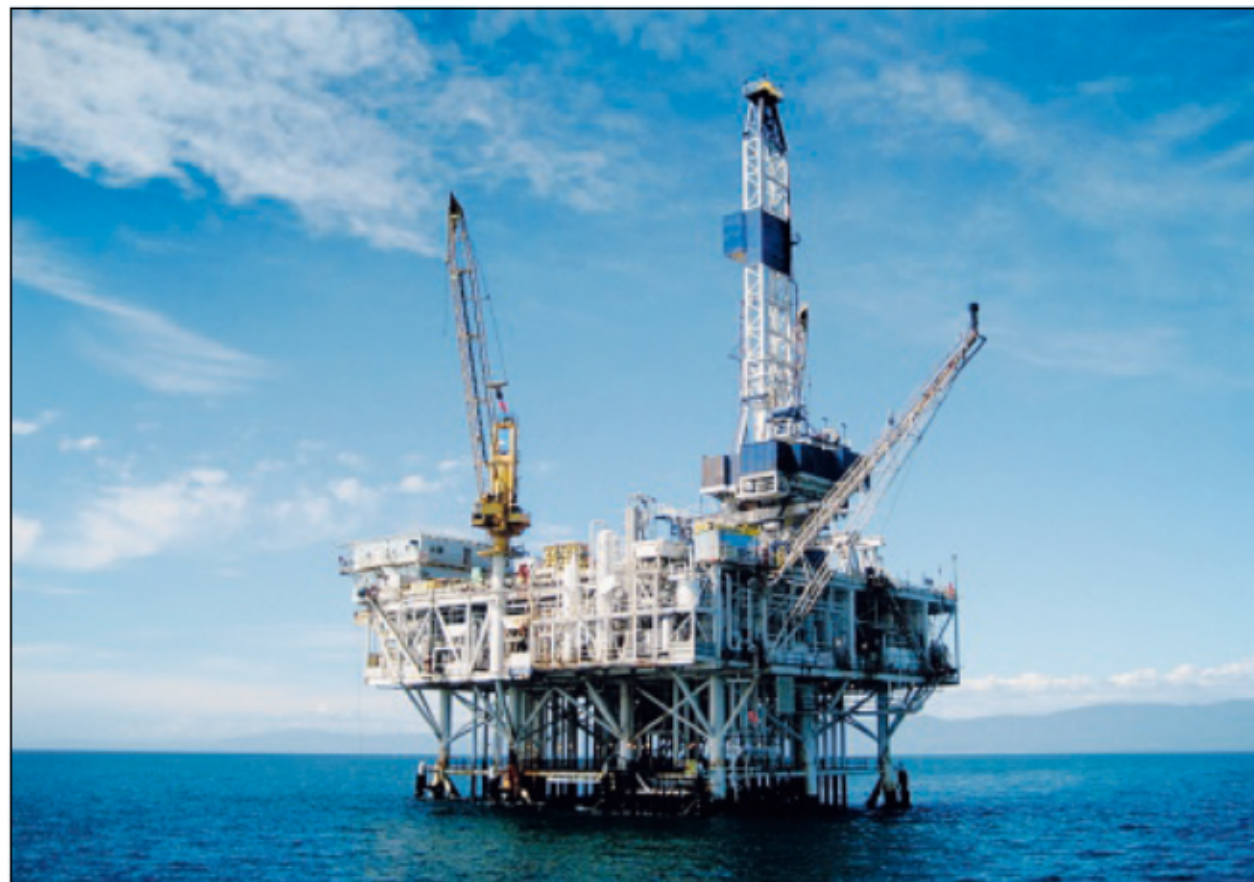
Estrazioni di idrocarburi in mare La questione torna ad agitare il Bassopolesine
